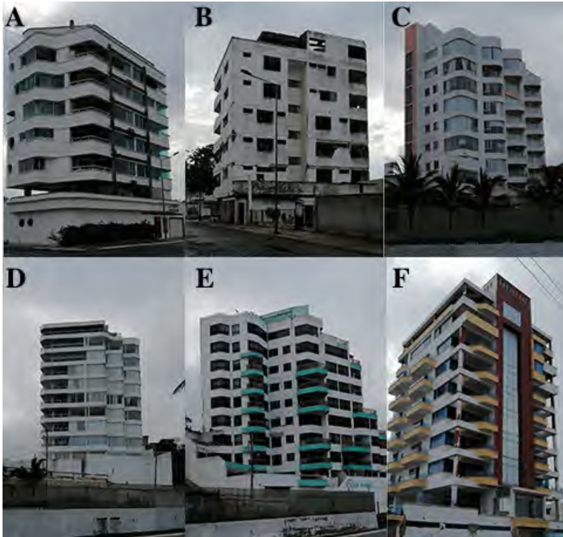
Figure 17. A: Agua Marina (#16); B: No name, damaged (#19); C: Sucre (#21); D: Horizonte (#22); E: Las Brisas (#23); F: Hotel Patricio's (#25).
